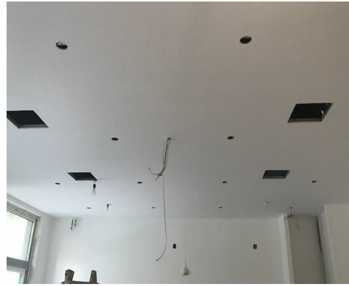
乳胶漆喷涂完成/确保所有顶面设施均匀授漆
