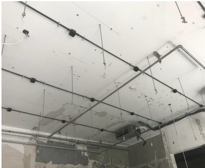
施工前确认管线及吊筋已制作完成
